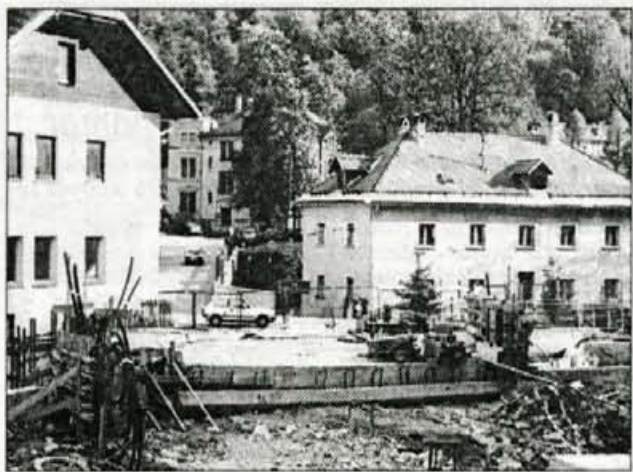
Tržič, 23. maja - Po izgradnji prvega mostu na tržiški obvoznici prek Tržiške Bistrice so lani poglobili strugo Mošenika in postavili drugi most v naselju Balos. Zaradi večjih stroškov od predvidevanj so po betoniranju plošče na drugem mostu dela obstala. Letos so se delavci SGP Tržič lotili izgradnje enostranskega pločnika in ograj, kmalu pa se bodo lotili postavitve opornih zidov in priprave dovozne ceste za asfaltiranje. Kot predvidevajo, naj bi 29 milijonov tolarjev vredna dela končali sredi avgusta, ko bo novi most tudi končno odprt za promet. Ta odsek obvoznice bo omogočil predvsem lažji in hitrejši dostop do zdravstvenega doma, kar je sedaj pri velikem številu vozil po ozki ulici v starem mestnem jedru največji problem. • S. Saje
