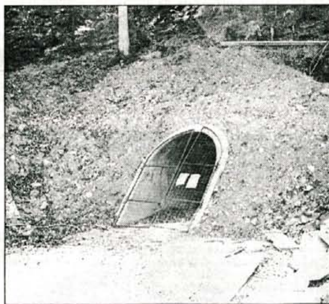
Vhod v rov pod jaloviščem Boršt s katerim so ustavili nevaren plaz
