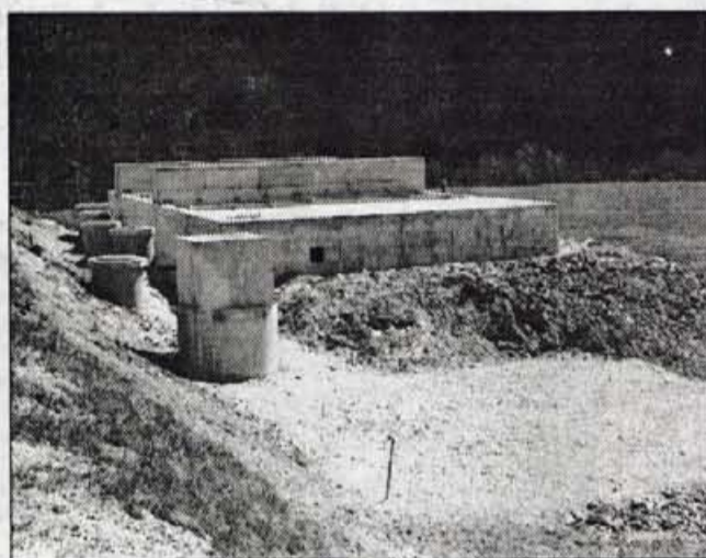
Gradbeno je čistilna naprava pri Poljanah gotova.
