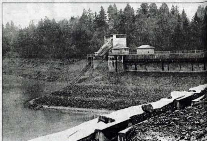
Jez na akumulacijskem jezeru na reki Lech.
