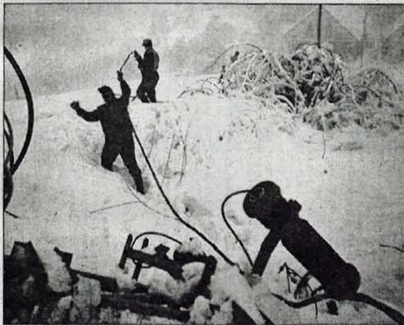
Zaradi pretrganih vodnikov so delavci Elektra Gorenjske provizorično potegnili snopasti izolirani kabel.
