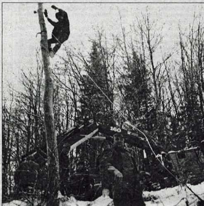
Zaradi nedostopnosti je postavljanje novih drogov potrebno opraviti ročno v težkih razmerah. Pretrgane vodnike je potrebno spojiti in potem ponovno napeti na drogu.
