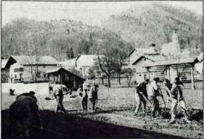
V soboto so ob šoli v Sori dokončali jeseni začeta dela.
