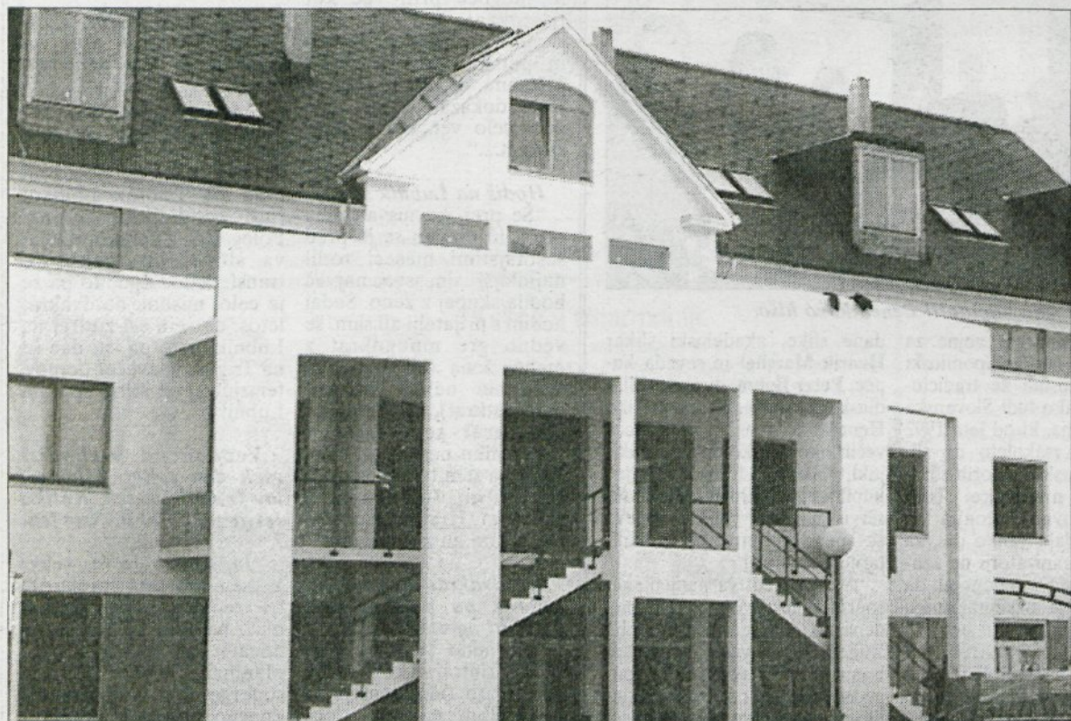
Poslovni center bo odprt v začetku meseca novembra.
