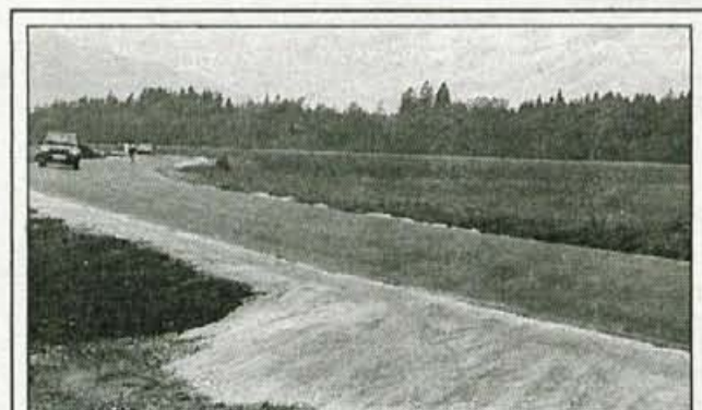
Šenčur, 27. septembra - Kranjska cesta v Šenčurju je že na novo asfaltirana, zdaj urejajo in utrjujejo še bankine. Domačini, ki so vajeni po tej cesti voziti v Kranj, že čutijo razliko. Minula zima je namreč Kranjsko cesto močno razdejala, tako da so jo vso luknjasto spomladi za silo zakrpali, na jesen pa je končana temeljitejša obnova. Občino Šenčur pa čaka še ena večja obnova, namreč cesta proti Britofu, ki je skupni projekt kranjske in šenčurske občine. • D.Ž.
