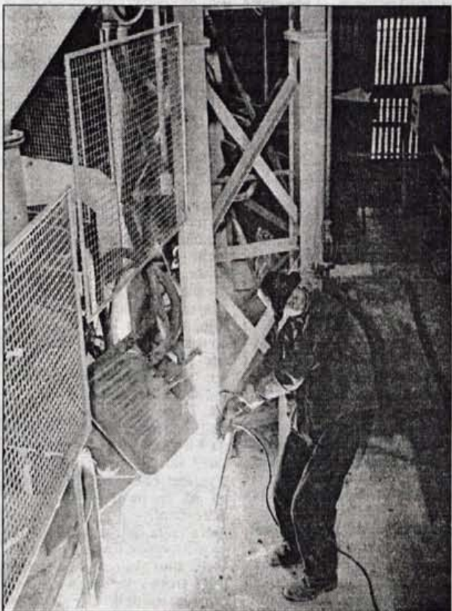
V jeklarni 2 na Koroški Beli delajo delavci v štirih izmenah. Na sliki: jeseniški jeklar preverja kakovost » šarža « iz peči, kjer se je pri temperaturi 1500 stopinj Celzija talilo visokokvalitetno nerjavno jeklo... - Foto: J.Pelko
