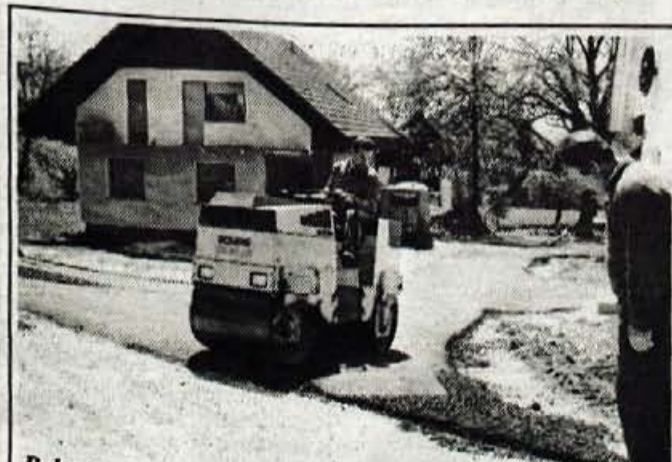
Paloviče, 8. maja - Nekaj več kot pol kilometra makadamske ceste med naseljema Paloviče in Leše, ki je bila komaj prevozna, ima od tega tedna drugačno podobo. Po rekonstrukciji cestišča so tam položili asfalt, obenem pa so uredili več odcefov po naselju. Po lani sklenjeni pogodbi naj bi dela stala 2,7 milijona tolarjev, zaradi dodatnih del pri širitvi ovinka, urejanju drenaž in asfaltiranju odcefov pa bo račun predvidoma poldrug milijon večji. Kot je povedal predsednik KS Leše Janez Bogataj, večino denarja prispeva tržiška občina, dodatna dela pa polovično financirajo krajanje. Ker gre za največjo naložbo v zadnjih letih, vas z nekaj več kot 50 prebivalci ne bi zmogla tako velikega bremena. Domačini so opravili veliko prostovoljnih ur pri pripravi trase, po potrebi pa bodo uredili tudi bankine. • S. Saje
