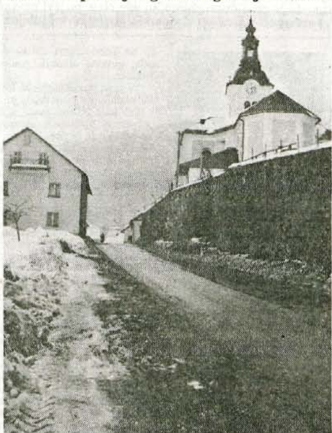
Cestna "ožina" v Selcih - med opornim zidom cerkve in župniščem ni dovolj prostora za obnovljeno cesto, zato se mora župnišče pred gradnjo ceste umakniti.
