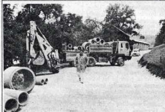
Gradbena dela morajo biti po programu končana do 20. septembra.
