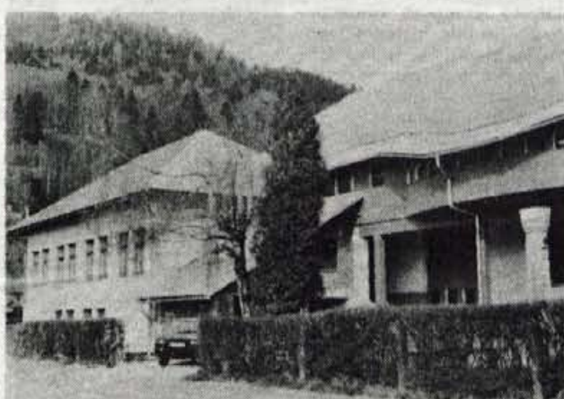
Stara osnovna šola na Blejski Dobravi se skriva za neumestnim gradbenim posegom - gasilskimi garažami in večnamensko dvorano...
