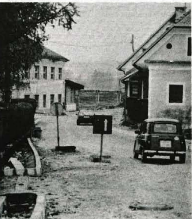
TA TEDEN GROBI ASFALT - Glavni izvajalec del na odseku povezovalne ceste v Križah, ki so jo po težkih pričakovanjih in zahtevah v krajevni skupnosti Križah začeli urejati že lani, je Cestno podjetje Kranj. Na najbolj zahtevnem odseku v Križah je SGP Tržič uredilo v cestni ču tudi kanalizacijo. V Cestnem podjetju Kranju so napovedali položitev grobe ga asfalta na cesti ta teden. Investitor del na tem delu regionalne je Republiška uprava za ceste. - A. Ž. - Foto: L. Jeras
