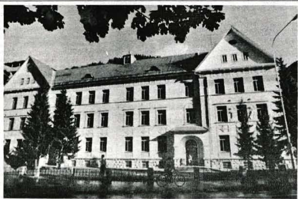
Izjemno lepa fasada obnovljene jeseniške gimnazije... - Foto: J. Pelko
