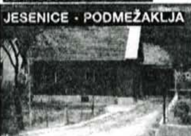
JESENICE - PODMEŽAKLJA Začeta gradnja stanovanjske hiše, oz. prizidka k starejši leseni hiši na zemljišču v izmeri 700 m2. Izdelana je prva plošča novogradnje - predvidena delavnica v pritičju. V času gradnje novega objekta je možno bivanje v starem objektu. CENA 58.000 DEM
