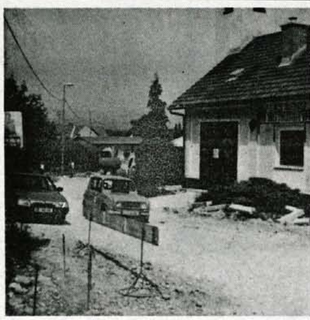
Potem ko so jo krajan pred nedavnim zaprti, so prejšnji teden začeli obnavljati regionalno cesto v Valburgi.
