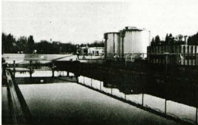
Čistilna naprava v Kranju
