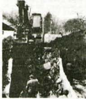
Glavni vod za plin na območju Golnika je že v zemlji.
