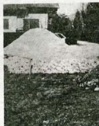
Na zgornji strani hiše: zloženo kamenje in kup izkopenega materiala.
