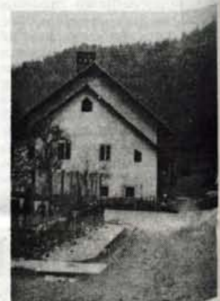
Lani so začeli urejati kanalizacijo in jo letos dokončali, preden pa 200 metrov ceste asfaltirali.
