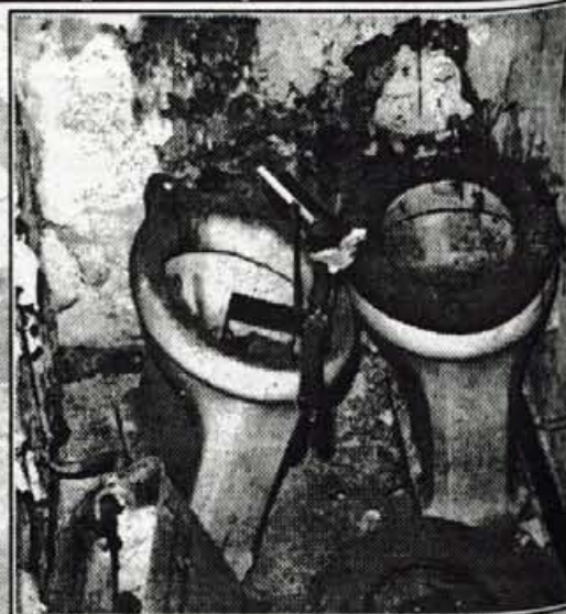
Stavba je v slabem stanju: pogled v stranišče
