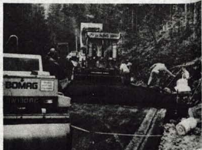
Čeprav so pri delih na cesti ta teden hiteli, bodo zaradi slabega vremena tako cesto po Melcovi grapi kot v Snopkovo dolino odprli na Martinovo nedeljo, 14. novembra.
