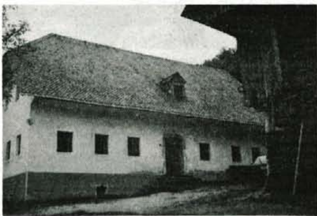
Jernejeva stanovanjska hiša v Krivem Brdu zgrajena leta 1866 in pokrita s skriljem. Graditi so jo začeli furlanski zidarji.
