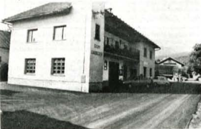
Pred dnevi so v Češnjeku in na Trati asfaltirali avtobusna izogibališča, v Velesovem pa okolico gasilskega in zadržnega doma.
