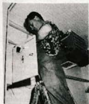
Tomaž Trobec iz ETP Kranj hiti z napeljavo zadnjih inštalacij.
