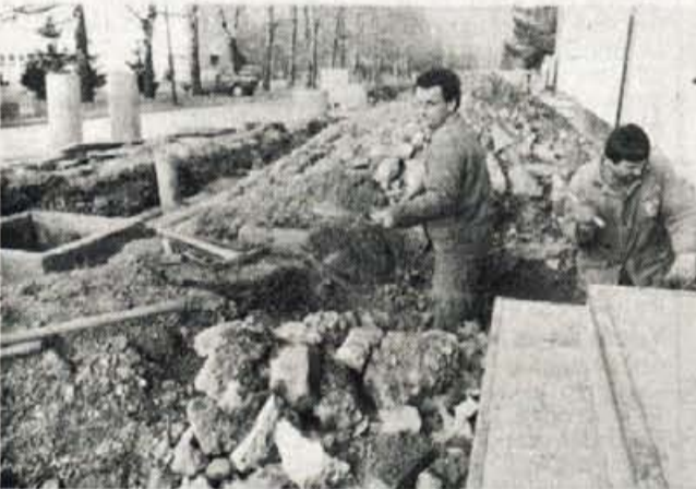
Pred ureditvijo okolice je na vrsti položitev talnih kablov
