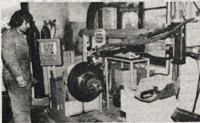
V Polixu so sami izdelali robotizirano napravo za visoko kvaliteto varjenja krogelnih pip. Izdelali je niso zaradi količine proizvodnje, marveč zaradi kvalitete.
