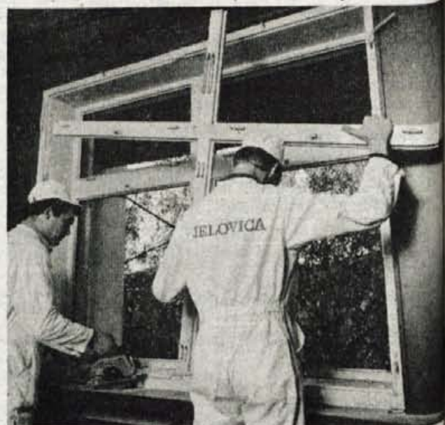
Odstranjevanje starega okna
