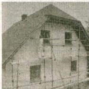
Nanašanje in končno obdelavo zaključnega sloja fasade lahko opravimo ročno ali strojno. Videz pa je enak vlečni bavarski fasadi.
