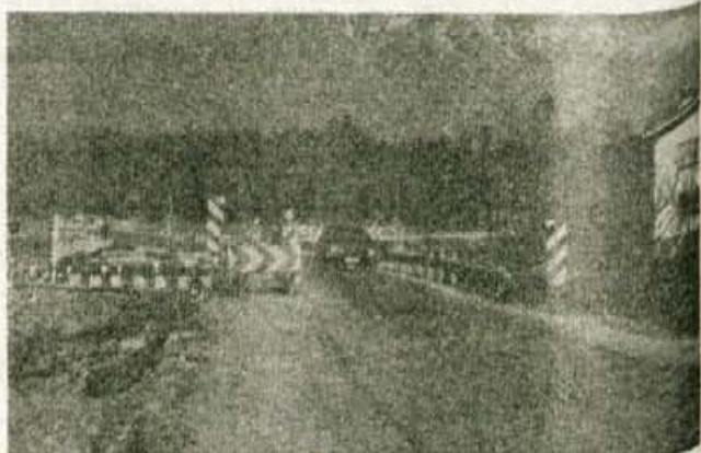
Most na Mlaki je trenutno glavno gradbišče na rekonstrukciji ceste Kranj-Golnik. Zaradi mraza pa je Vodnogospodarsko podjetje Kranj moralo dela prekiniti...
