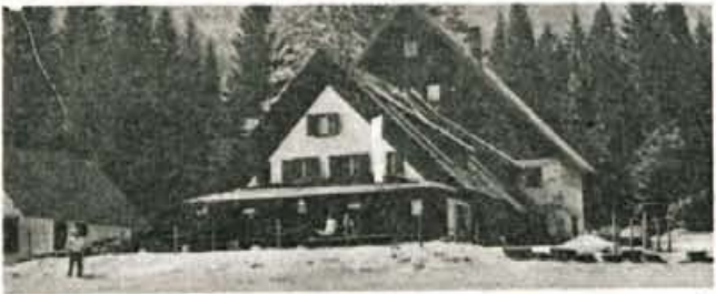
Na strehi dotrajane planinske koče v Tamarju so stare lesene deščice, na drvarnici poleg koče pa moderna »teglac... Foto: D. Sedej
