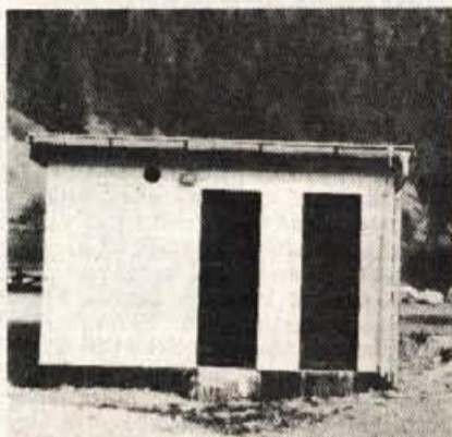
Avtomatska telefonska centrala za 160 priključkov je že postavljena. Zdj jih čaka le še skupna akcija...
