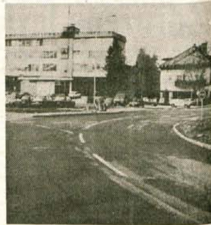
Med večja letošnja dela sodi tudi ureditev križišča in parkirišča v Radovljici, kjer dela pravkar končujejo...
