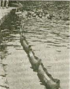
Savske zavese proti razburkanim valovom. Na blejsko jezero jih je položilo Vodnogospodarsko podjetje Kranj.
