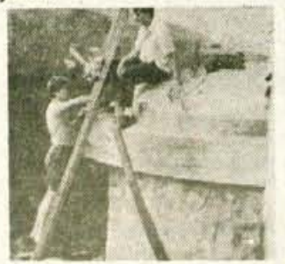
Bohinjski gasilci so že zgodaj popoldan pripravili cevi s črpalko, improvizirani vodomet pod mostom.
