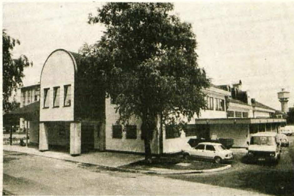
Kranj, 31. julija - Ob kranjskem občinskem prazniku so danes popoldne odprli v Kranju nov poštni center, ki je pridobitev za vso Gorenjsko, saj se bodo tam zbirale vse poštne pošiljke, ki prihajajo ali odhajajo z Gorenjske. Dnevno je to približno 75 tisoč pisem, paketov in časopisov, ki so težki 40 ton. Hkrati pa bo to glavna pošta mesta Kranj, tam bodo na voljo vse PTT storitve, ki jih je doslej opravljala osrednja kranjska pošta v starem delu mesta (tudi poštne predali), le-ta pa bo postala podružnica. V lepem posloplju, ki so ga uredili iz nekdanje kranjske pekarnice, je uporabljenih 2.500 površinskih metrov prostora, približno 1.000 površinskih metrov pa je namenjenih kasnejši razširitvi dejavnosti. Preračunano v sedanjo vrednost je gradnja veljala 20 milijard dinarjev. M. V. Foto: F. Perdan
