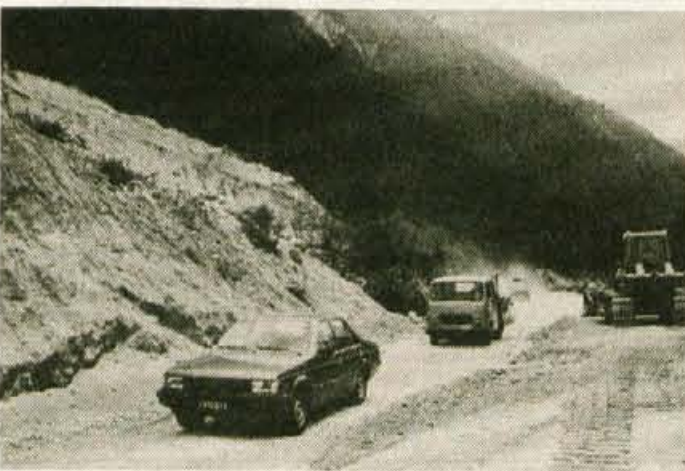
Med največje in najbolj potrebne cestne obnove sodi rekonstrukcija in razširitev ceste od Martuljka do Belce na magistralni cesti od Jesenic do Kranjske gore. - Foto: Gorazd Šinik
