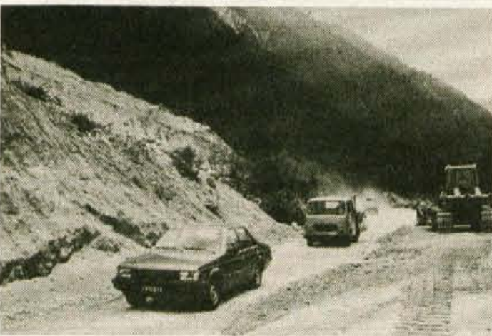
Med največje in najbolj potrebne cestne obnove sodi rekonstrukcija in razširitev ceste od Martuljka do Belce na magistralni cesti od Jesenic do Kranjske gore. - Foto: Gorazd Šinik
