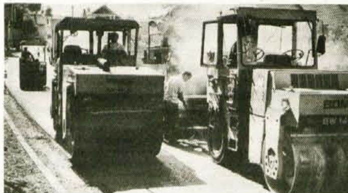
Cesto skozi Studeno proti Zeleznikom so prejšnji teden na grobo asfaltirali. Finega asfalta še ne bodo dajali, ker čakajo, kdaj bo odpravljeno zadnje ozko grlo; dogovorjen odkup in porušena hiša, ki stoji na bodoči razširjeni cesti. - H. J., foto F. Perdan
