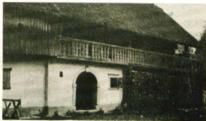
Samo še spomin — Kmečka hiša iz prve polovice 19. stoletja s slamnato streho, lesenim gankom in portalom iz zelenega kamna iz Srednje vasi pri Kranju. Arhiv ZSV SR Slovenije.
