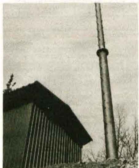
12. decembra sta bila stolp in pretvorniška hišica na Kršišu gotova...
