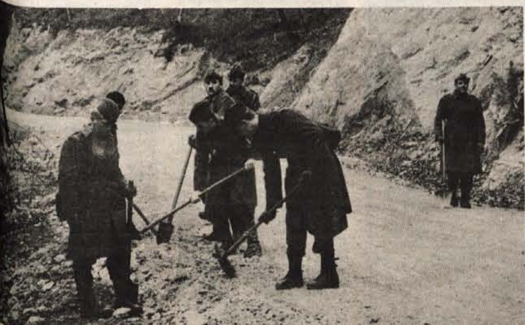
Delovna akcija vojakov in domačinov pod Križno goro - Za prebivalce 16 domačin na Križni gori je bil v preteklosti največji problem slab dostop do vasi. Ob pomoči krajevne skupnosti Podlubnik-Stara Loka so se to poletje lotili rekonstrukcije in razširitve ceste, vendar stroji niso mogli opraviti prav vseh del. Zato so krajanji za pomoč naprosili pripadnike armade iz škofojloške vojašnice, ki niso odrekli njihovi prošnji. Tako je skupina 50 vojakov ob vodstvu starešin iz inženirske enote 12. novembra sodelovala pri planiranju cestnih robov, urejanju kanalov in čiščenju travnikov ob cesti skupaj s člani Lovske družine Križna gora in domačini. Čeprav je bilo vreme hladno, so se udeleženci pri delu kar dobro zagreli. Še bolj kot to pa jih ogrela hvaležnost domačinov, zato se bodo ob potrebi mednje radi vrnili. (S. Saje) - Foto: G. Šinik
