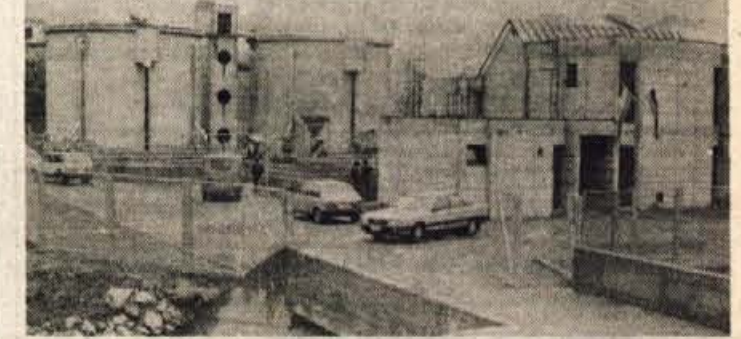
Nova mestna čistilna naprava na Jesenicah ima zmogljivost 30.000 ekvivalentov ali za 30.000 prebivalcev. Nanjo se bodo uporabniki priključevali postopoma, tudi s Hrušice in s Koroške Bele. Foto: F. Perdan
