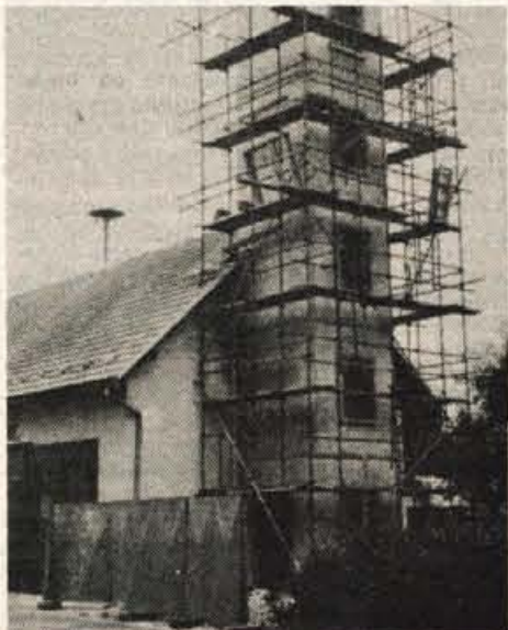
Prihodnja sobota bodo gasilci in z njimi vsi, ki so pomagali, praznovali izgradnjo novega gasilskega stolpa...
