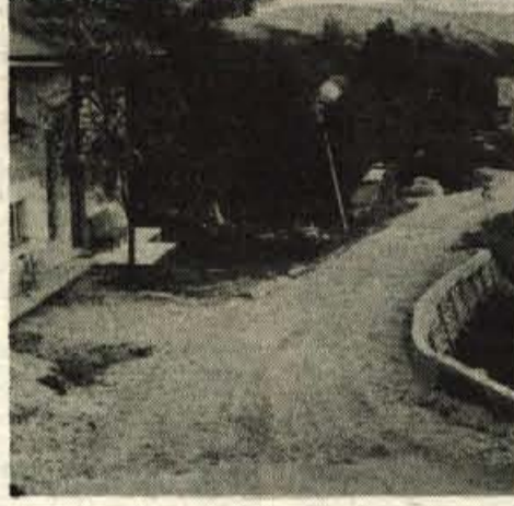
Spornih in neasfaltiranih 35 metrov topoljske ceste - Slika: F. Perdan
