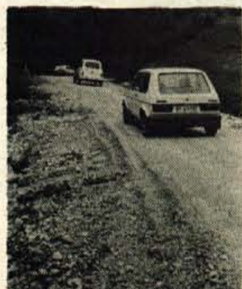
Ker ni urejeno odvodnjavanje, vsak naliv razjeda cesto in odnaša nasutje.
