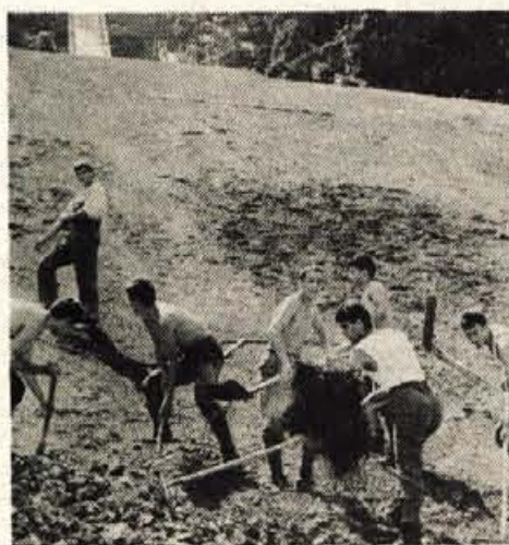
Pri gradnji kranjskega skakalnega stadiona pomagajo tudi vojaki. — Slika: F. Perdan
