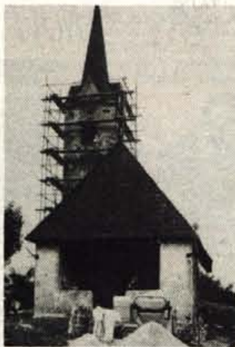
Ob pomoči kulturne skupnosti in pod strokovnim nadzorom Zavoda za spomeniško varstvo iz Kranja so začeli obnavljati cerkvico sv. Marka v Vrbi.
