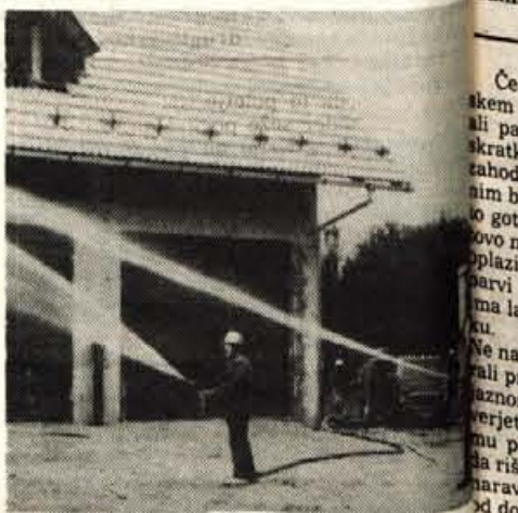
Gasilci v Kovorju gradijo nov gasilski dom. V petek so pred domom imeli tudi gasilsko vajo.
