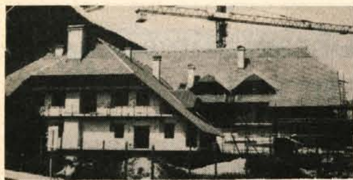
Kranjskogorski nakupovalni center že pod streho - Delavci jeseniškega Gradbinca hitijo z deli pri gradnji kranjskogorskega nakupovalnega in stanovanjskega središča. V njem bodo stanovanja, ki jih težko pričakujejo delavci kranjskogorskih turističnih in gostinskih delovnih organizacij, samopostrežna trgovina ter lokali, ki bodo popestritev kranjskogorske izvenpenzijske ponudbe, obenem pa pridobitev za Kranjskogorce. Objekt je zgrajen v alpskem stilu, predvidevajo pa, da ga bodo slovesno odprli letos novembra. - Foto: D. Sedej
