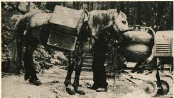
V veliko pomoč pri gradnji novih stopnic je tudi konj. Edino prevo- zno sredstvo, ki zmore visoko v breg.
