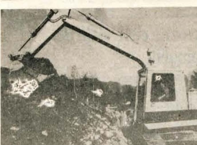
**Tržička kanalizacija — Tudi lani so v Tržiču nadaljevali s postopnim urejanjem kanalizacije. Tako sta Vodnogospodarsko podjetje Kranj in SGP Gradbinec gradila kolektor in kanal na Loki. Letos naj bi nadaljevali mimo Peka proti bodoči čistilni napravi. — D. Papier**
