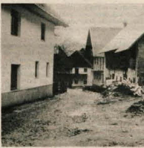
V Studorju so lani s prostovoljnimi delom in prispevki obnovili prvi del vodovoda.
