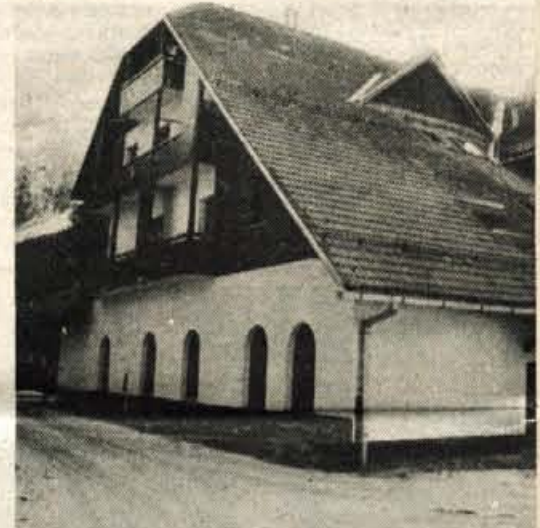
Po gradnji vodovoda je zdaj na vrsti Korotan...
